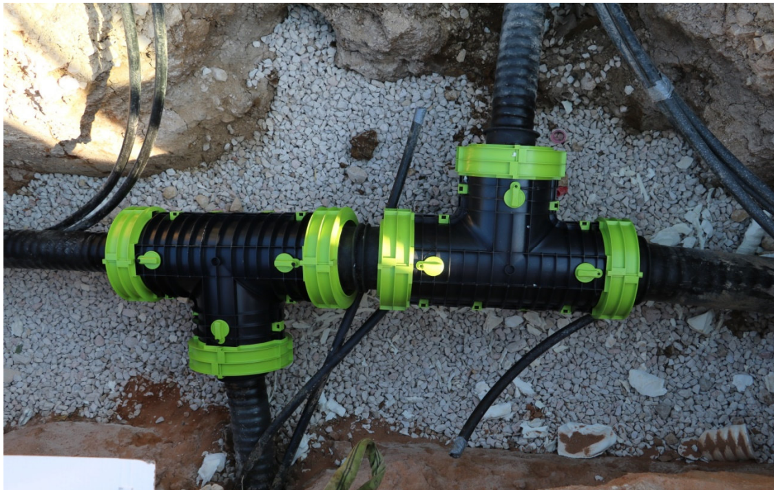
T-Stück im offenen Graben
