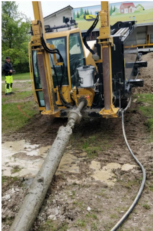
Grabenlose Verlegung im günstigen Spülbohrverfahren
