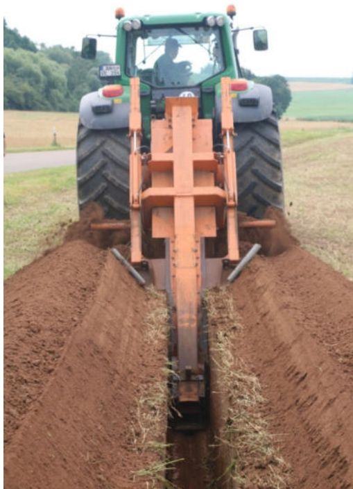
Grabenfräse + Verlegung der Wärmerohre
