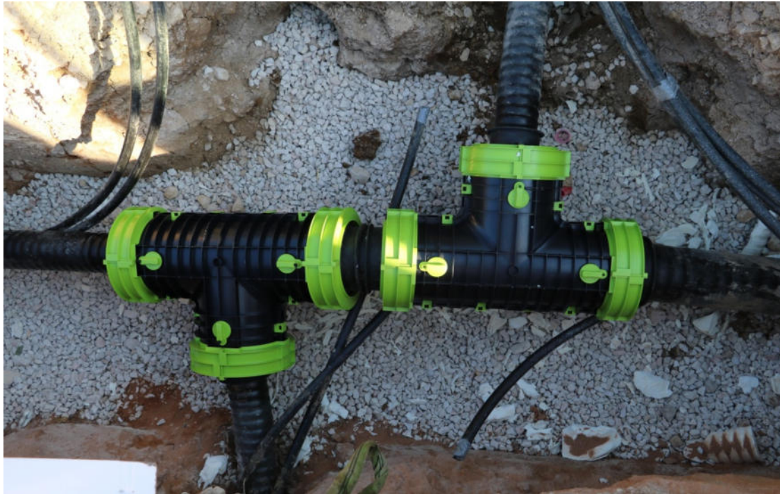
T-Stück im offenen Graben
