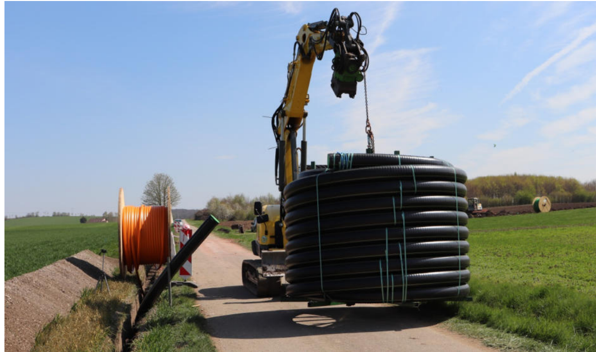
Grabenfräse + Verlegung der Wärmerohre
